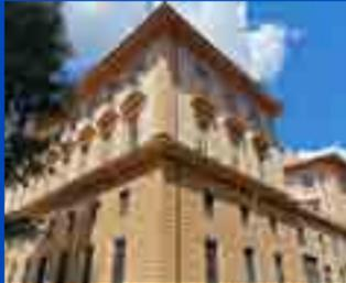
prospicienti sul cortile interno. Le facciate sono caratterizzate da cornici, mostre di finestre, lesene e rivestimenti in pietra e stucco che definiscono in maniera chiara lo spartito dell'edificio, dall'attacco a terra fino al cornicione di copertura.
