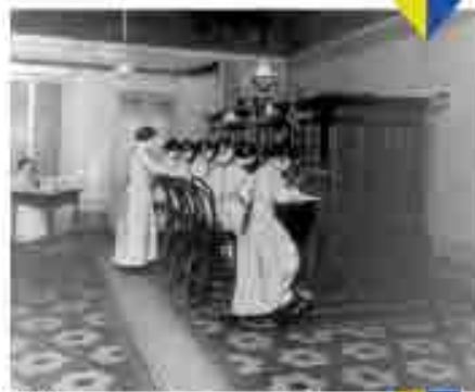
1895, una sala di commutazione urbana con sistema Kellogg
